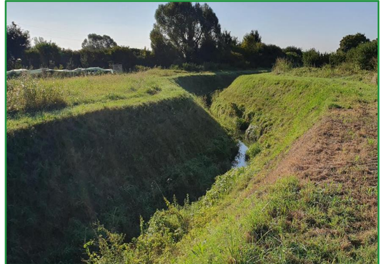
Slika 4. Potok Glavničica – početak trase, neobloženo korito, mjestimično erozija obale (Izvor: Tau projekt d.o.o.)
