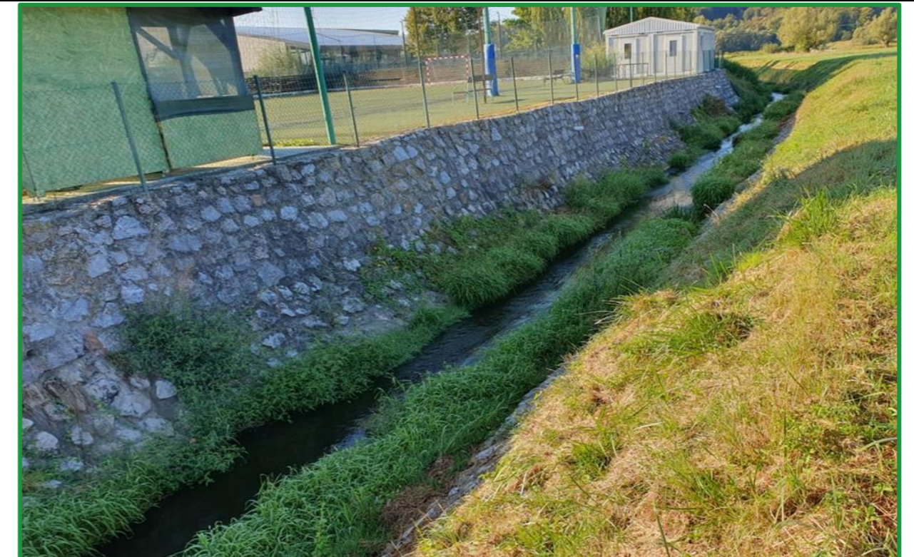
Slika 14. Potok Glavničica, obloga korita uz bazenski kompleks, uzvodno od dionice koja je predmet Elaborata (Izvor: Tau projekt d.o.o.)
