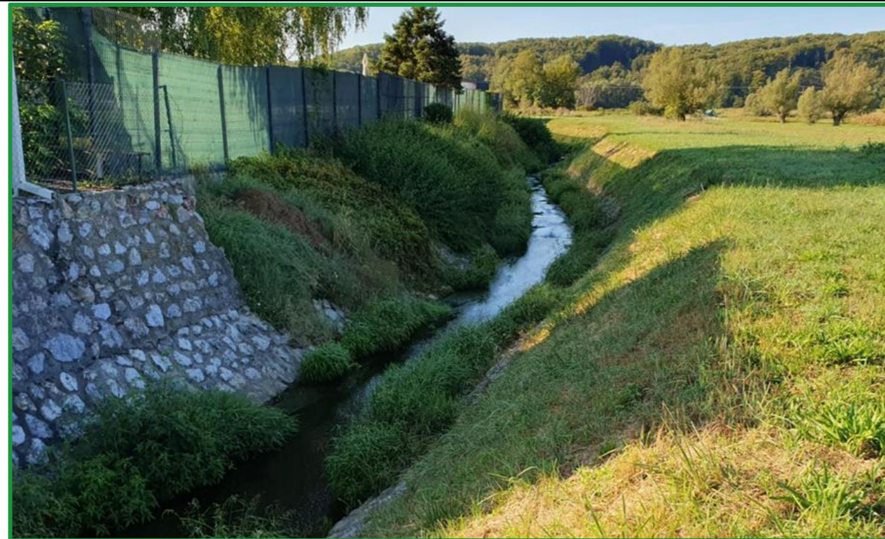
Slika 13. Potok Glavničica – kraj projektirane dionice na dijelu gdje počinje obloga korita (Izvor: Tau projekt d.o.o.)
